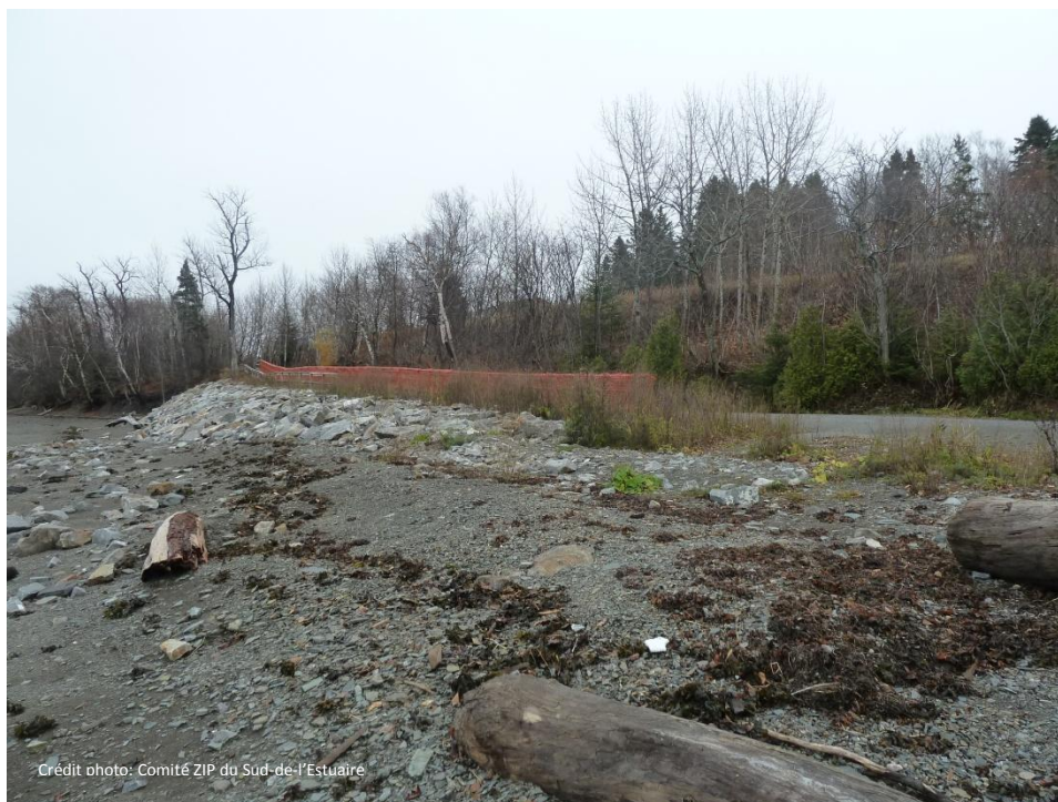
Figure 2. Enrochement à proximité des sites de restauration, mis en place après la tempête en 2010 pour protéger la piste cyclable
