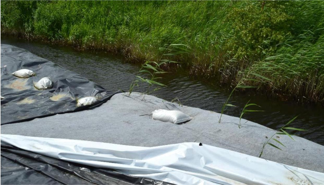
Figure 11 Jonction de géomembranes déplacées durant l'hiver. Notez que le géotextile à lui seul ne suffit pas à freiner les repousses de roseau commun.
