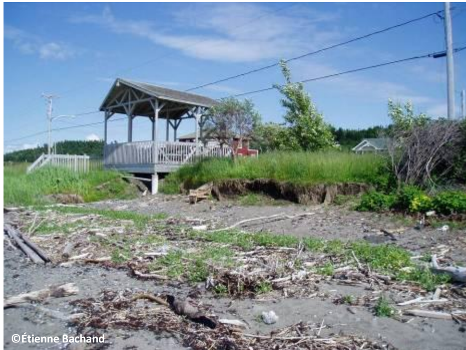
Figure 2. Aménagements municipaux endommagés, microfalaise et débris mis en place lors de la tempête du 6 décembre 2010.
