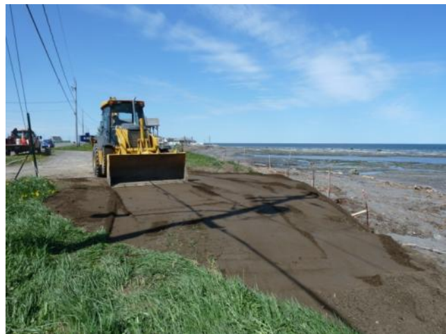
Figure 6. Mise en place des sédiments
