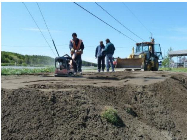
Figure 7. Compactage des sédiments à l'aide d'un compacteur manuel.
