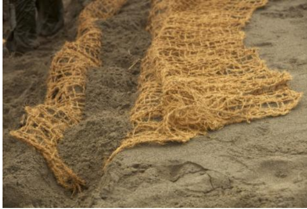
Figure 10. Installation du filet stabilisateur dans une tranchée
