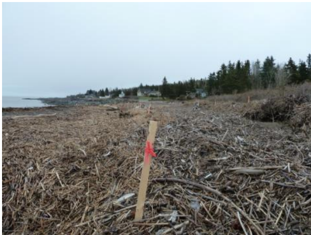
Figure 6. Balisage de la zone des travaux entre la ligne de rivage et la microfalaise.
