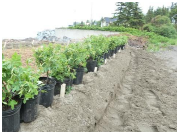
Figure 16. Plantation du rosier inerme dans une tranchée de 20 cm à la base de la recharge sédimentaire.
