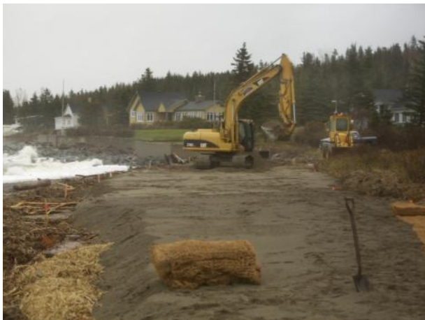
Figure 8. Mise en place des sédiments.
