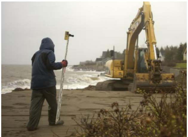
Figure 9. Compactage des sédiments et vérification du profil
