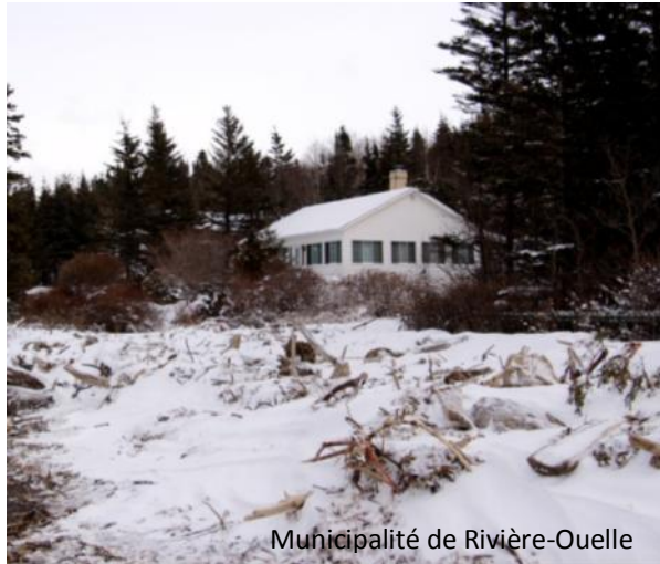
Figure 2. Site avant les travaux démontrant des perturbations naturelles (débris de la tempête du 6 décembre 2010) sur la plage et le chemin des Jésuites.
