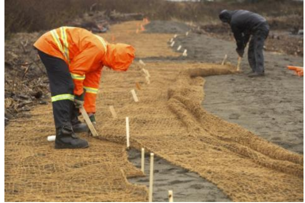
Figure 11. Installation de piquets de bois pour maintenir le filet
