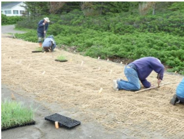
Figure 15. Bénévoles exécutant la plantation au travers du filet stabilisateur.
