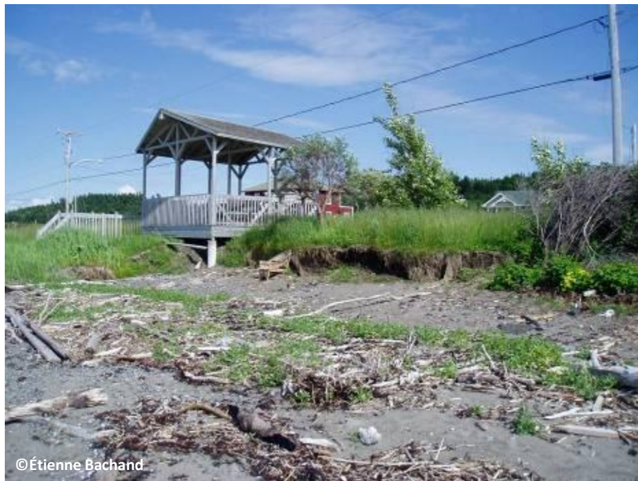
Figure 2. Aménagements municipaux endommagés, microfalaise et débris mis en place lors de la tempête du 6 décembre 2010.
