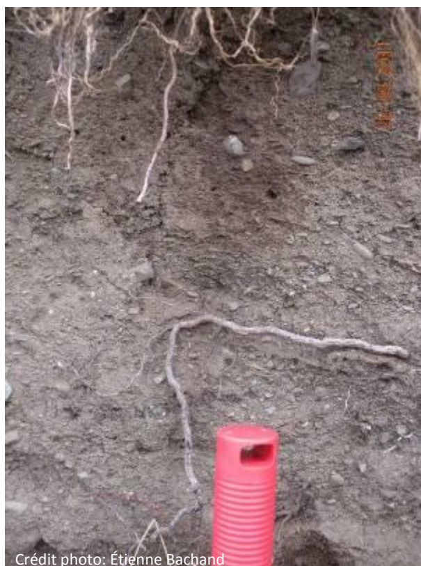
Figure 7. Matériau de remblai qui compose la terrasse de plage mise en place lors de la construction de la route 132 et de la halte.
