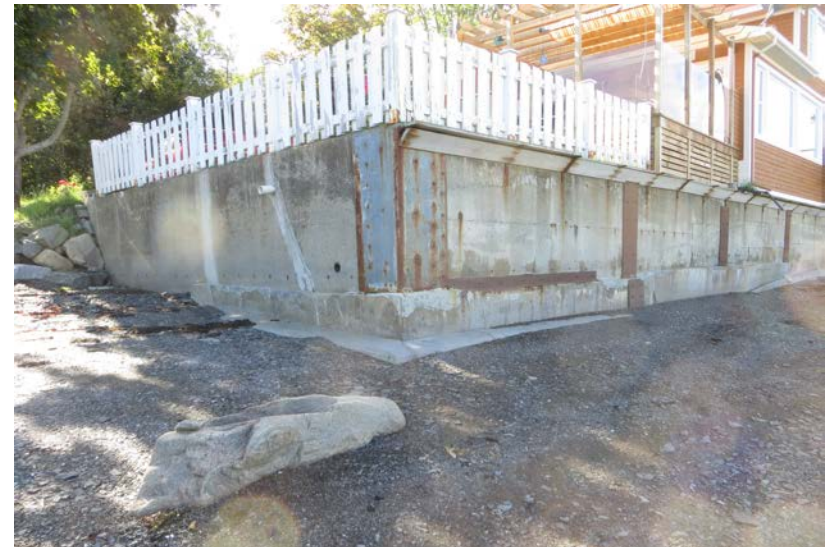
Fig. 55. Extrémité nord du mur de béton au 160 route du Fleuve. Fin du secteur où sera implanté le nouvel ouvrage
