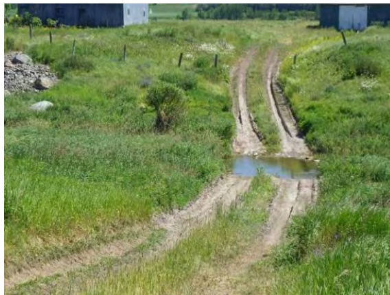
Figure 30: Traverse à gué présente sur la rivière Centrale
