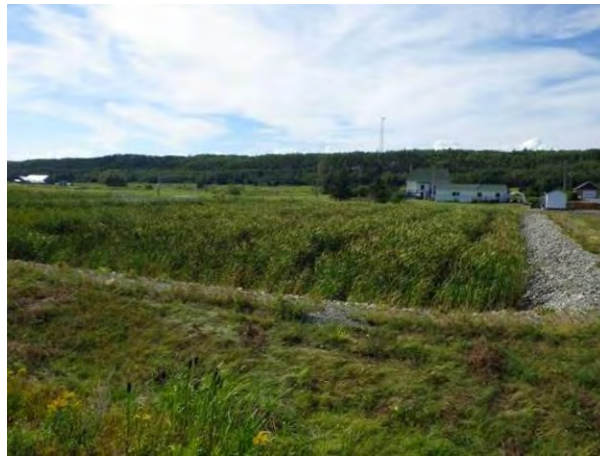
Figure 25: Marais filtrant de la municipalité de Saint-Simon
