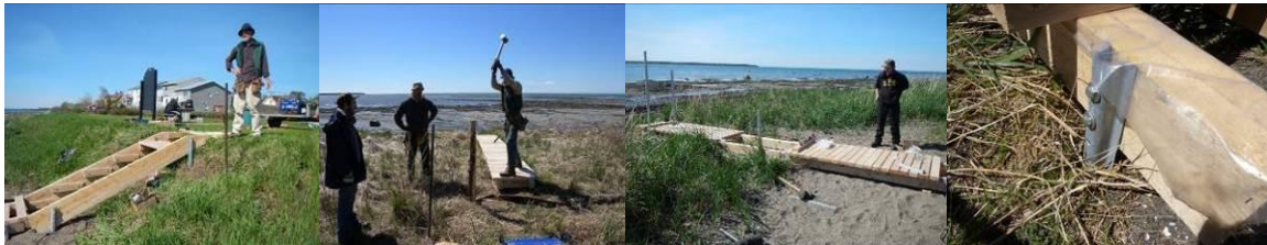
Figure 1 Installation des trottoirs et du balisage des accès
