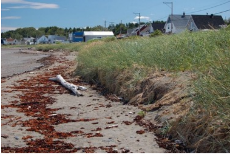
Figure 28. Érosion sur la haute-plage végétalisée
