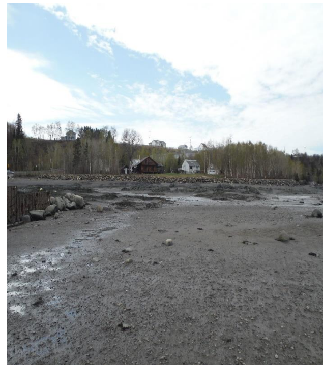
Figure 44 : Berge stabilisée au moyen d'enrochement près des habitations et de la route
