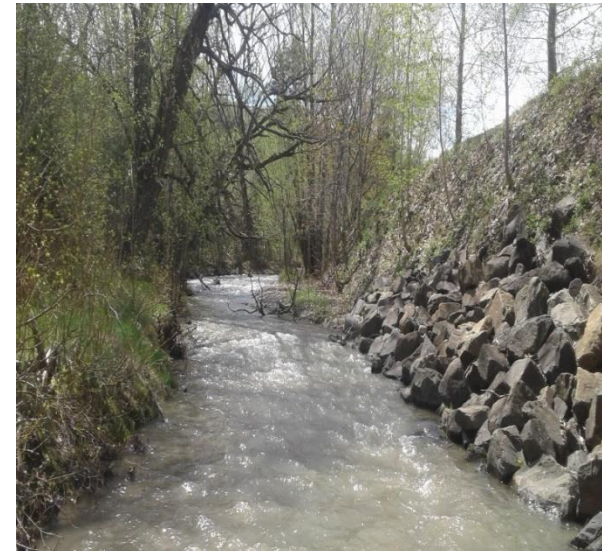
Figure 18 : Écoulement vue vers l'amont
