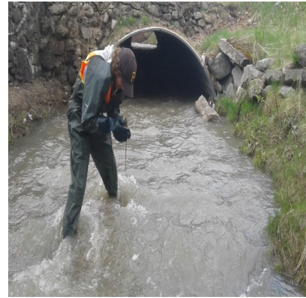
Figure 14 : Accélération du courant au niveau du ponceau
