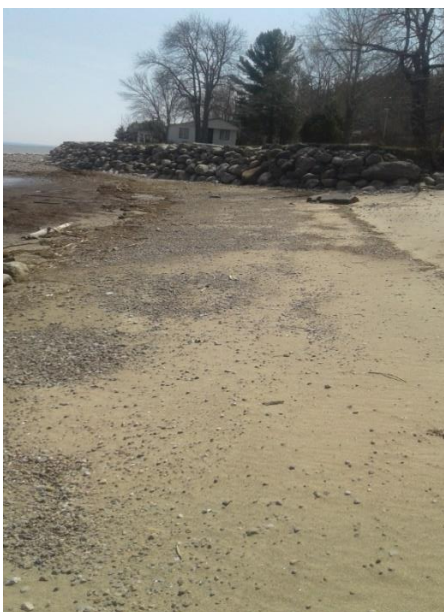
Figure 41 : enrochement contrôlant l'érosion de la berge
