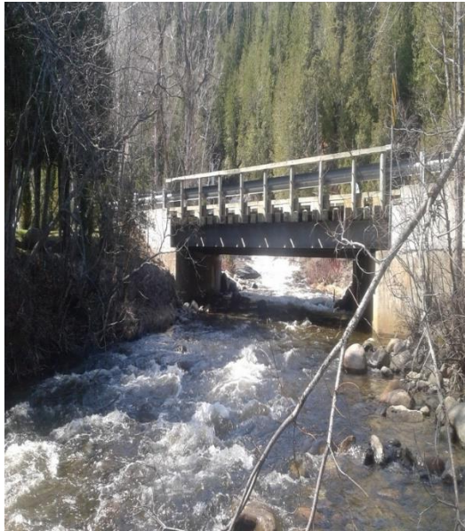
Figure 5 : Vue vers l'amont, la chute infranchissable est à quelques mètres en amont du pont
