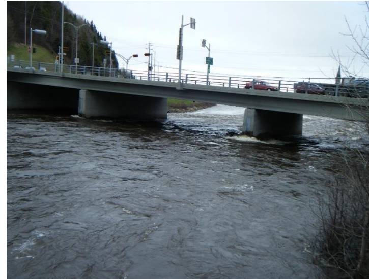
Figure 20 : Le niveau d'eau et le courant ne permettent pas l'inventaire
