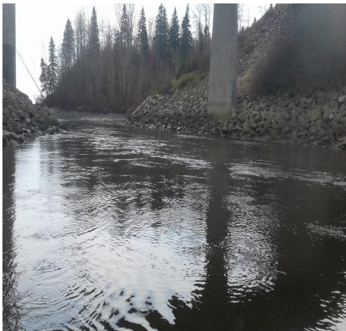
Figure 23 : Section 1 de la rivière au Canards, vue vers le fleuve
