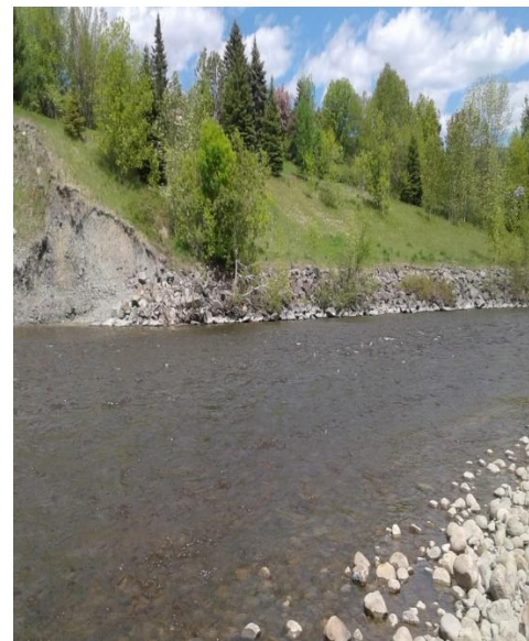
Figure 10 : Vue vers l'aval, une partie de la rive est artificialisée
