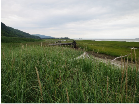
Vue de l'amont vers le quai
