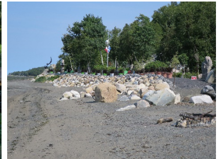
Enrochements dans le littoral
