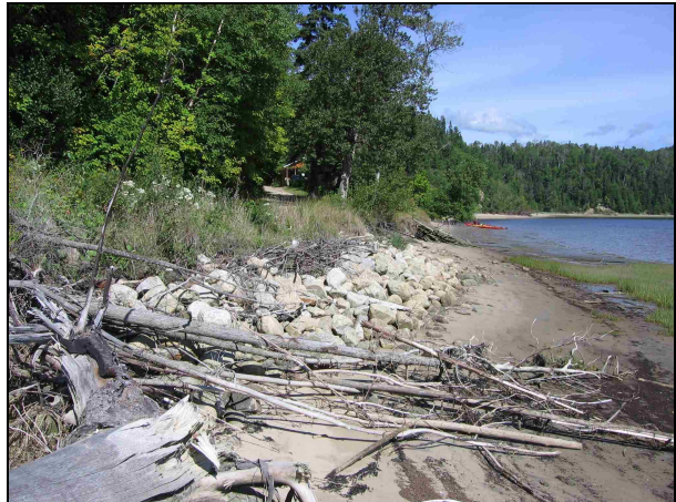
Photo 8 : Enrochement à proximité du chemin d'accès au chalet
