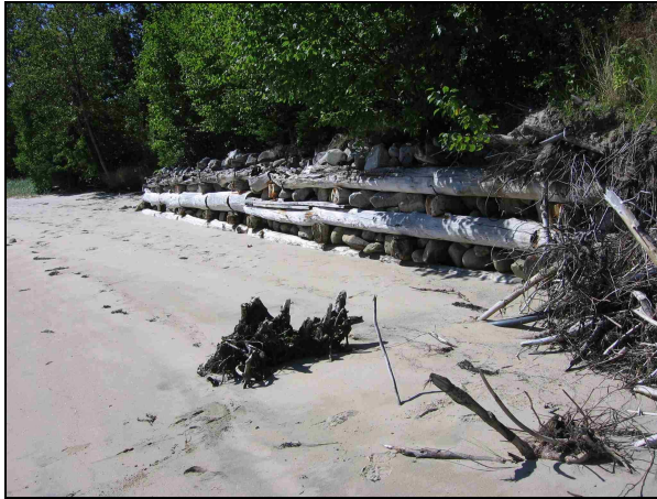
Photo 7 : Enrochement près du stationnement
