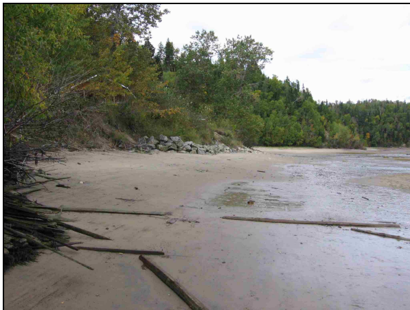
Photo 9 : Enrochement à proximité du chalet
