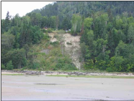
Photo 8 : Glissement de terrain
