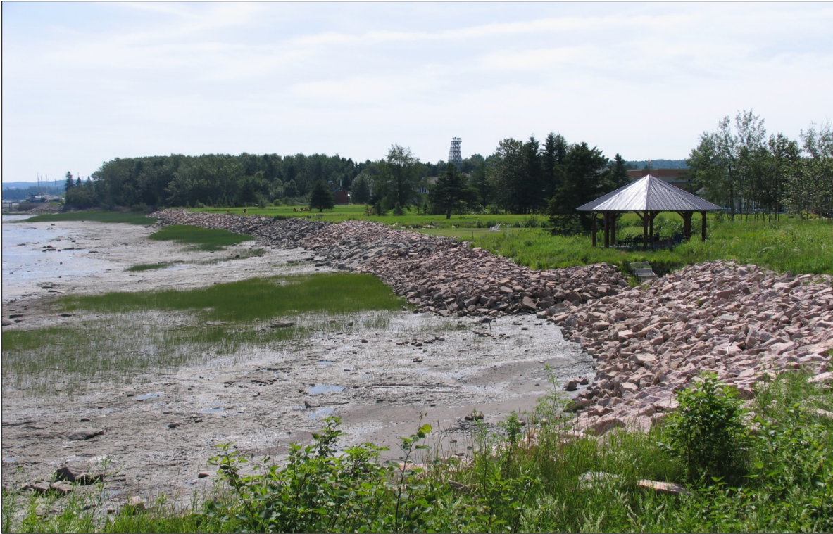
Figure 11. Exemple de l'état de la rive et de la bande riveraine, secteur 5.
