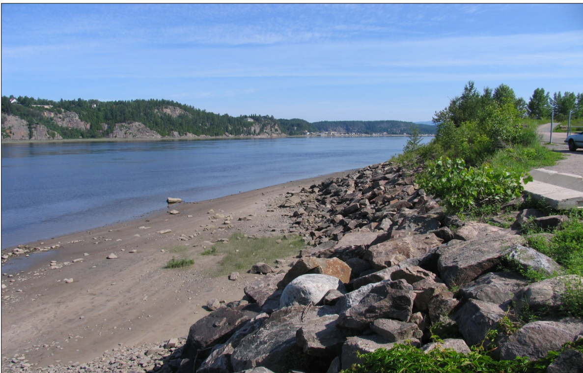
Figure 10. Exemple de l'état de la rive et de la bande riveraine, secteur 4.
