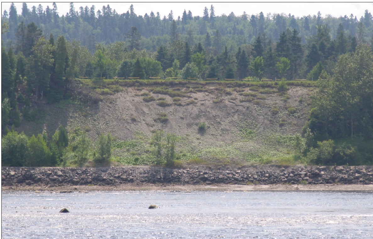
Figure 8. Exemple de l'état de la rive et de la bande riveraine, secteur 2.
