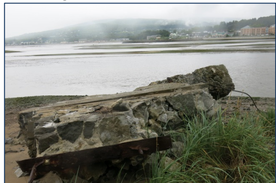
Vieux morceau de béton
