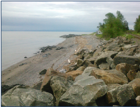
Quelques plages caillouteuses sont présentes entre les remblais
