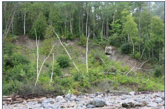
Décrochement de talus
