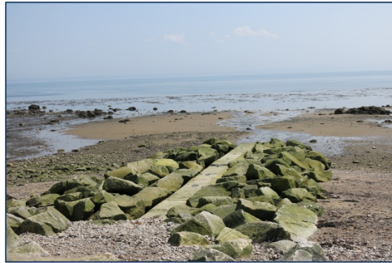
Rejet de l'égout sanitaire
