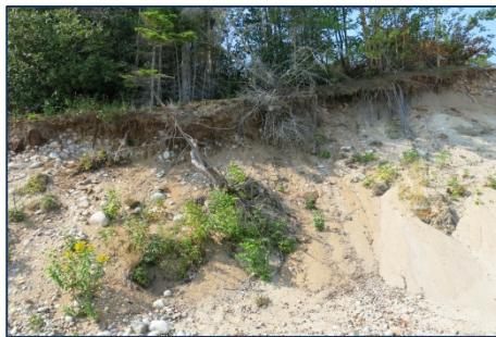
Décrochement du talus en milieu forestier
