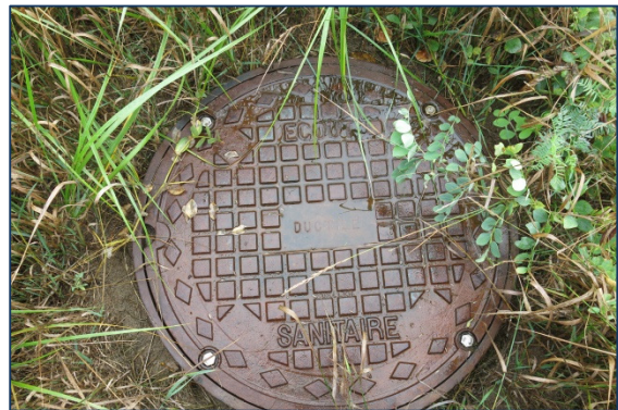
Égoût sanitaire dans marais 7
