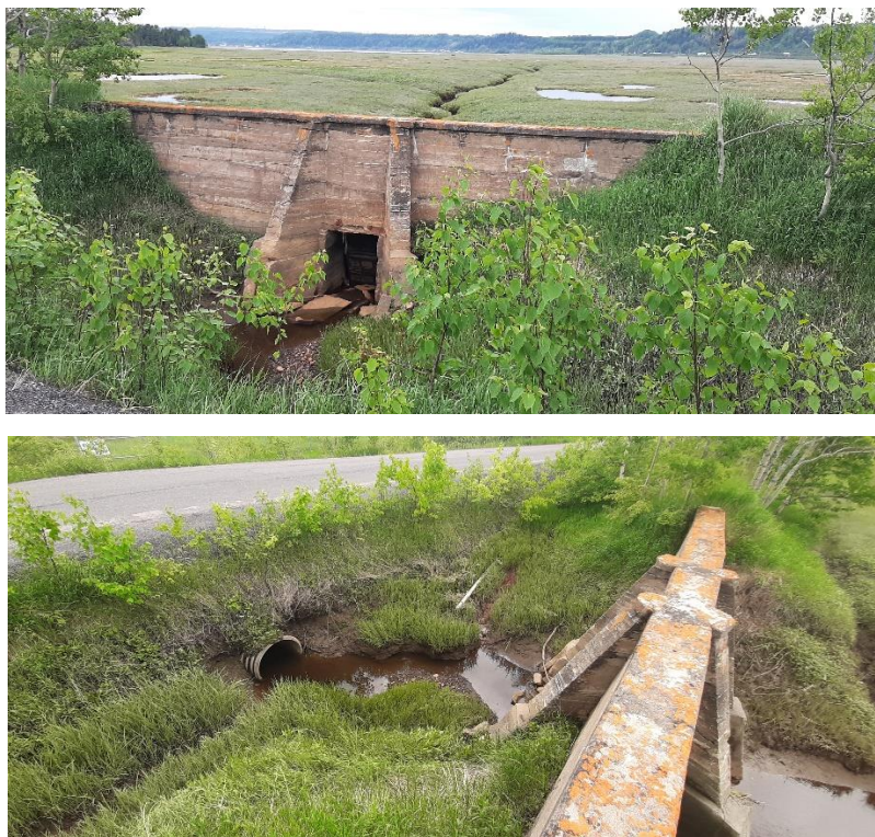
Figure 42. Vue de l'aboiteau en direction du marais abrité, secteur de la BMV est (en haut) et vue du dessus de l'aboiteau en direction du chemin d'accès, le chemin du Barrage (2022).
