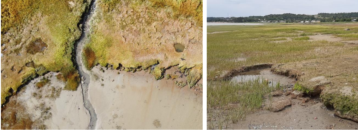
Figure 55. Microfalaise d'érosion dans la partie ouest du secteur de Saint-Paul-du-Nord (à gauche) et microfalaise d'érosion dans la partie est de ce secteur (à droite) (2021).
