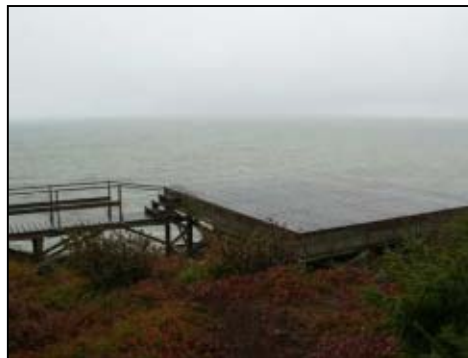
Photo 19 - Plate-forme d'hélicoptère sur le Cap Colombier
