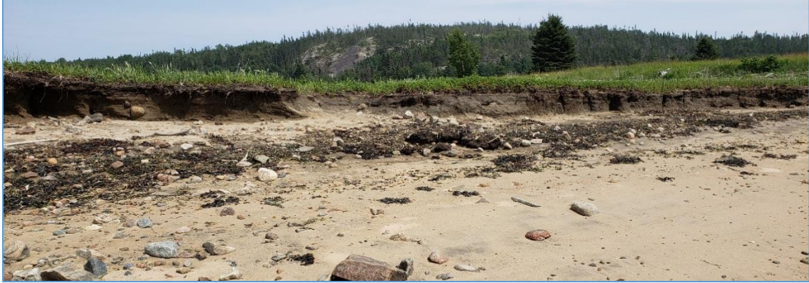
Figure 10. Érosion par sapement basal à la base de la digue (Comité ZIP RNE, 2021).
