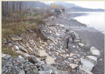
Endommagement endommagé à Saint-Omer, 2005
