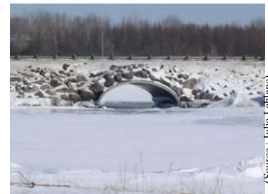
Ponceau sous le pont-jetée de la route 132
