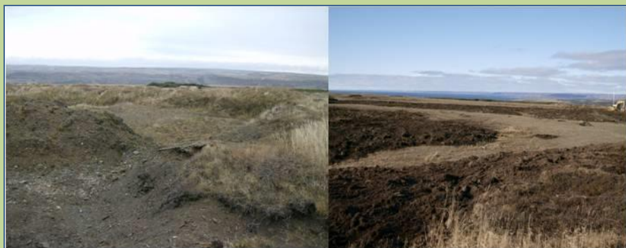
Figure 24. Avant / Après le rabaissement des remblais et buttes
