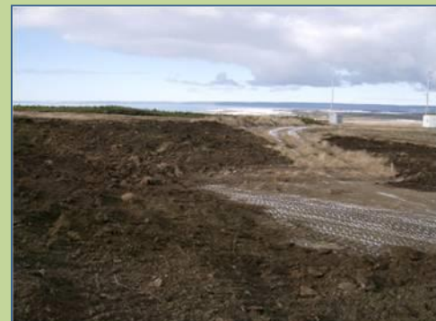
Figure 25. Relocalisation de la voie d'accès
