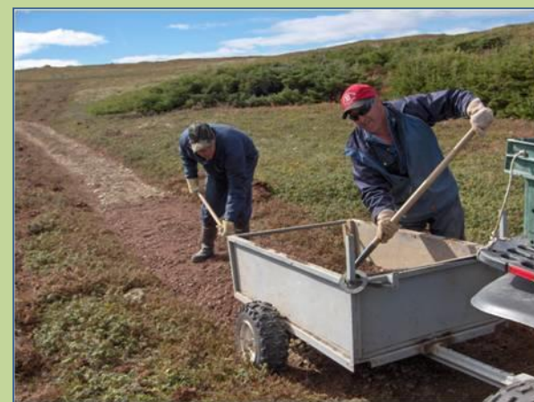
Figure 27. Lit de calcaire concassé
