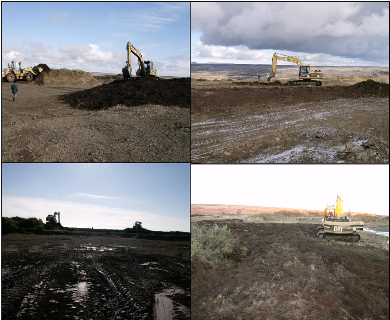
Figure : Les travaux de réhabilitation
