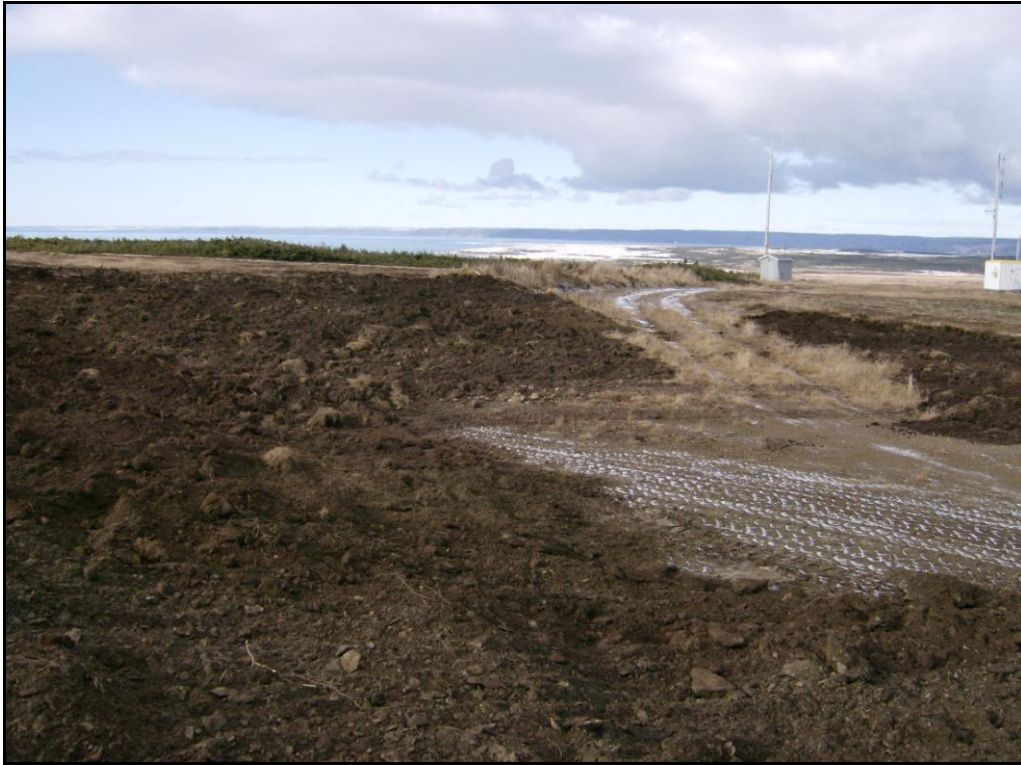
Figure 29 : Relocalisation du chemin d'accès
