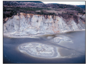
Glissement de terrain
