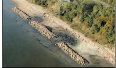
Accumulation de sable derrière les brise-lames et érosion entre les structures
