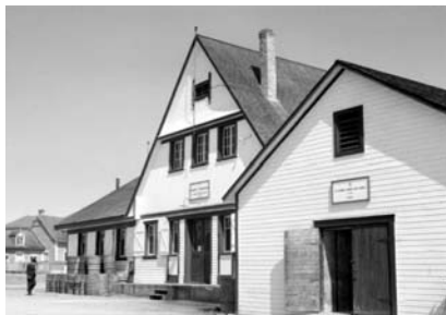
Un entrepôt frigorifique à Havre-Saint-Pierre (Photo : E.L. Désilets, 1947) Localisation : Centre d'archives de Québec de BANQ
