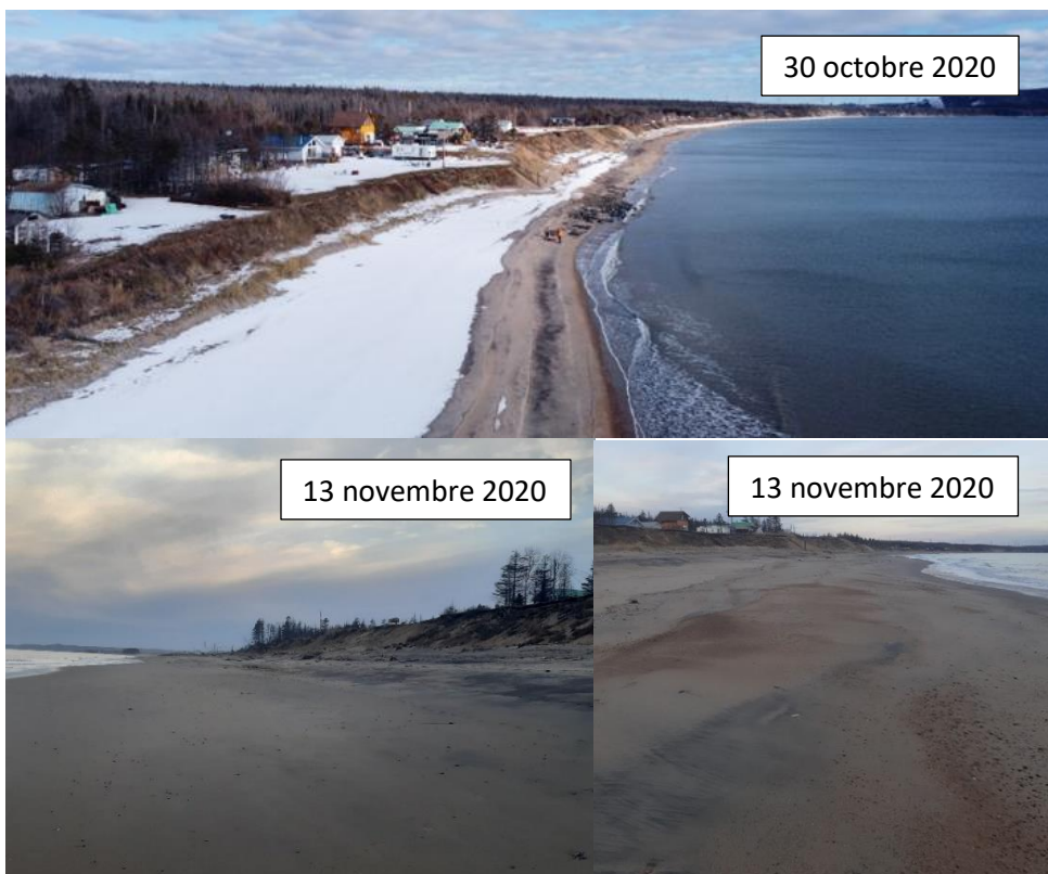
Figure 6. Évolution de la plage les semaines subséquentes aux travaux
