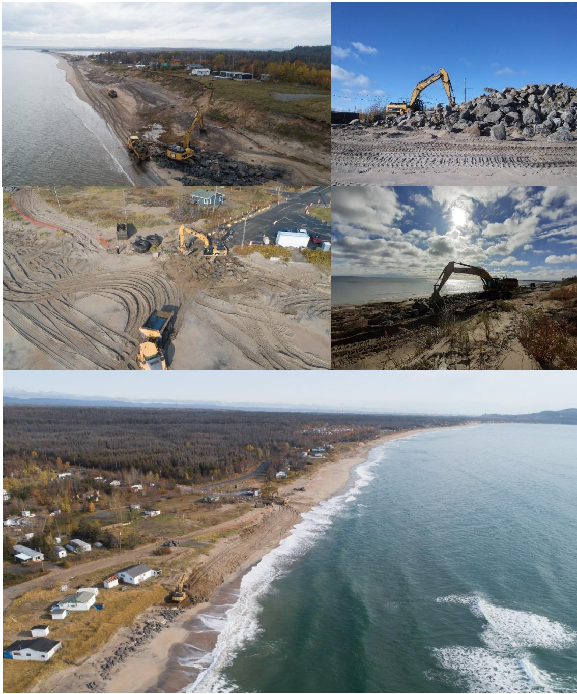
Figure 3. Images du déroulement des travaux
