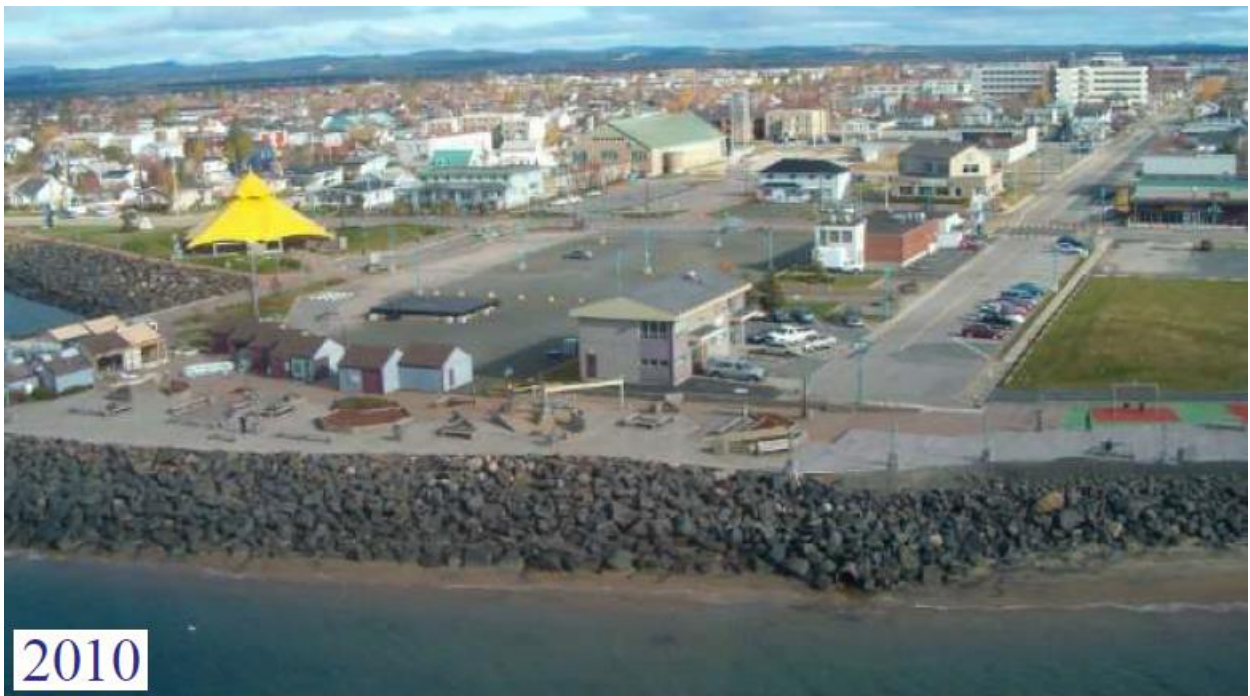
Figure 2.13 Secteur au sud du vieux quai de Sept-Îles en 2010
