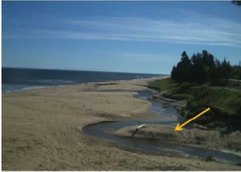
Figure 9. Vue vers l'embouchure du chenal PEN D et les vestiges du remblai (crédit photo : Caron, 2013)
