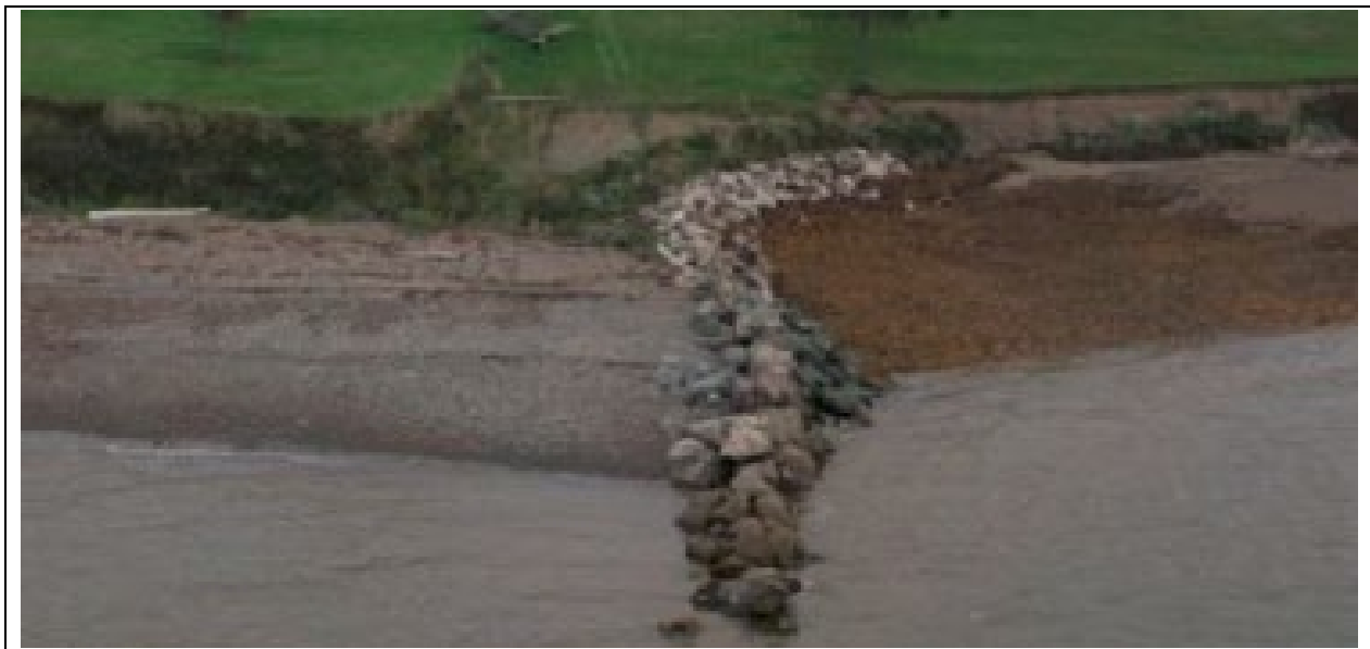
Photo 20. Exemple d’épi en enrochement semi-perméable (Source UQAR, 2016).
