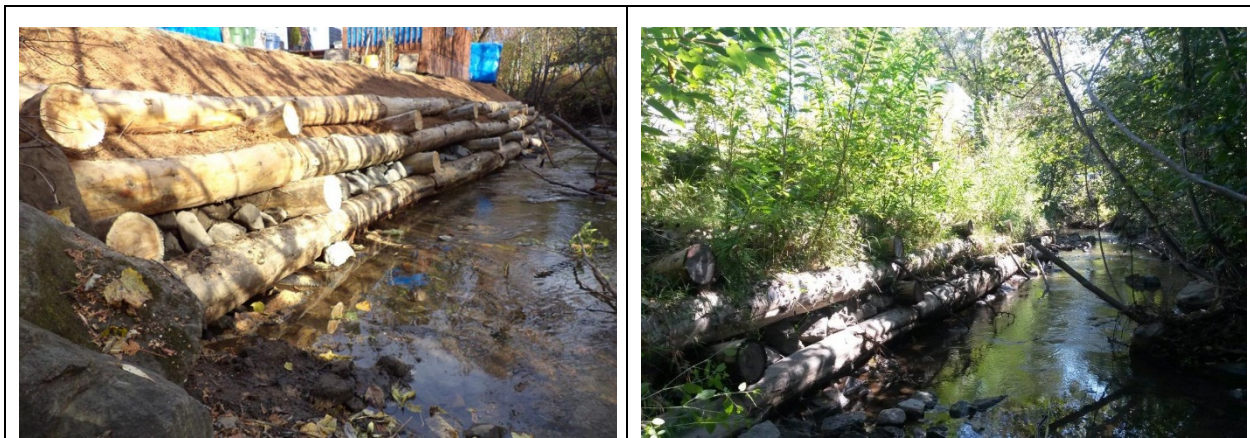
Photo 17 et Photo 18. Exemple, avant et après la naturalisation, de caisson de bois le long d’un ruisseau. Réalisation d’Aubier environnement (avec autorisation).
