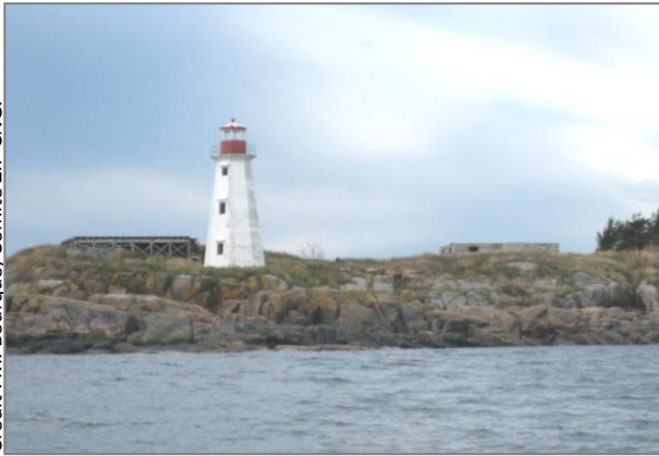
Figure 1.4. Phare de l'île aux Œufs. Plate-forme d'hélicoptère (gauche) et ancienne fondation (droite).
