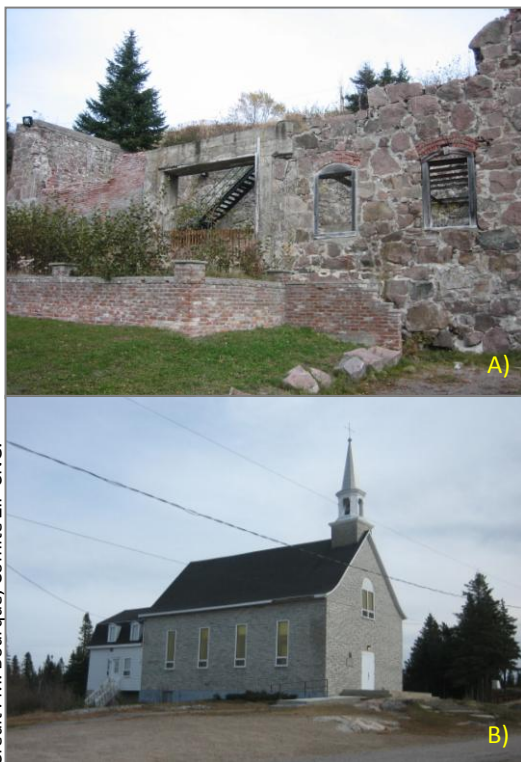
Figure 2.6. A) Ruines de l'ancien garage de la compagnie CIP ; B) Église paroissiale de Rivière-Pentecôte.
