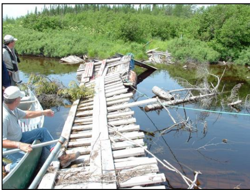
Figure 8.5. Pont de fortune fabriqué pour les Véhicules Hors Route (VHR). Crédit photo: G. Parenteau.
