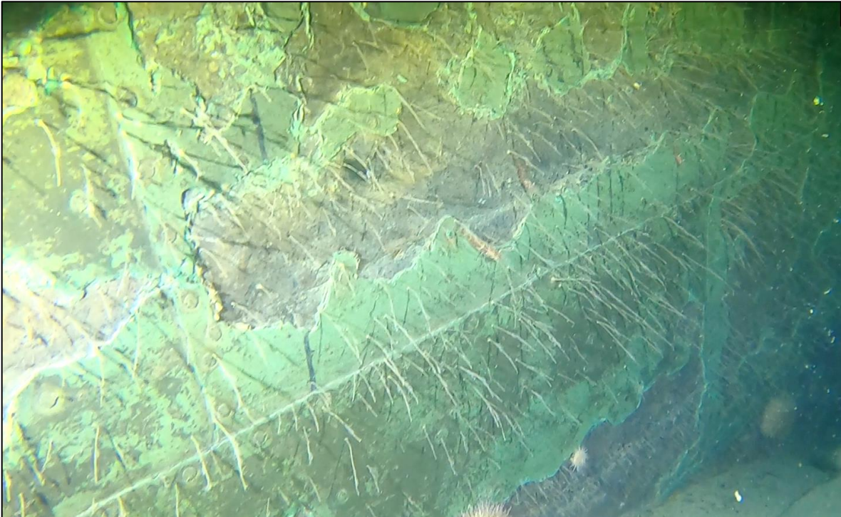
Figure 9 Recouvrement protecteur en laiton, image prise avec une GoPro (Olivier Barthell dans IRHMAS 2021)
