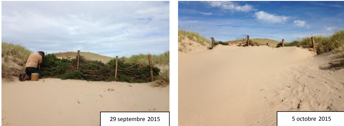
FIGURE 2 : PHOTOS INSTALLATION ET ÉVOLUTION D'UNE FASCINE EN 1 SEMAINE
