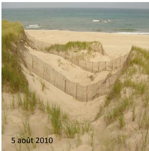
Photo 2 : Ganivelle lors de l'installation (à gauche) et après 1 an (à droite)
