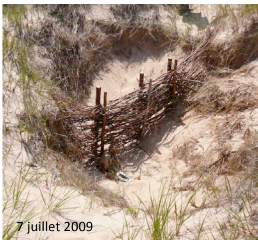
Photo 1 : Fascine lors de l'installation (à gauche) et après 1 an (à droite)
