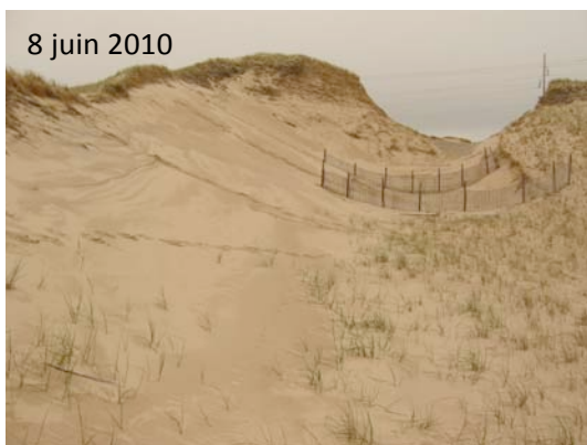
Photo 7 : Fixation de l'arrière dune dans le but de protéger les infrastructures routières (lors de l'installation d'une première série de ganivelles à gauche, 1 an après l'installation)
