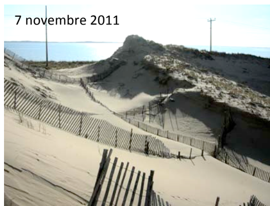
Photo 7 : Fixation de l'arrière dune dans le but de protéger les infrastructures routières (lors de l'installation d'une première série de ganivelles à gauche, 1 an après l'installation)
