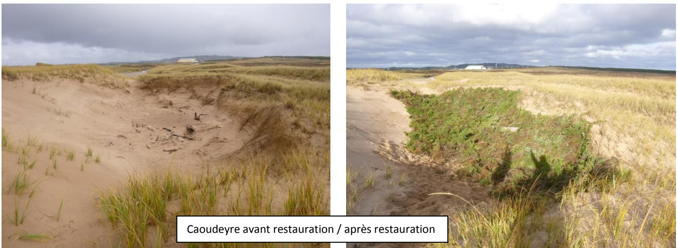
Figure 10 : Restauration par tapis de branchage du site COR028
