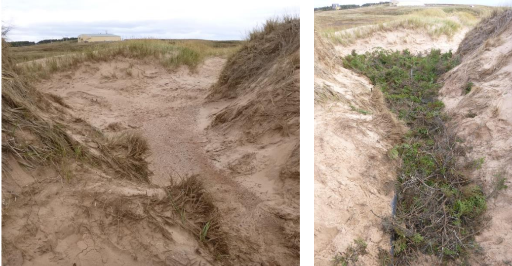
Figure 6 : Photo de la mise en place d'un tapis de branchage en octobre 2016 (Dune de l'Ouest)
