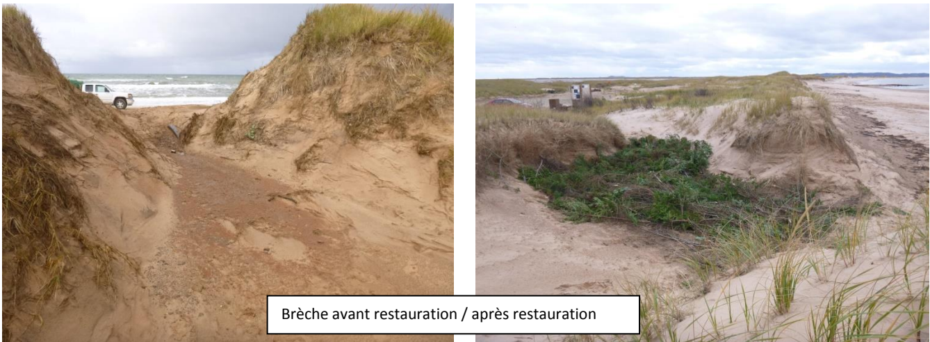
Figure 9 : Restauration par tapis de branchage du site COR027
