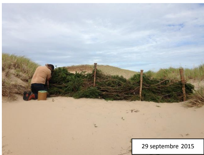
Figure 5 : Photos d'installation et d'évolution de fascine en 1 semaine (exemple de travaux antérieurs)
