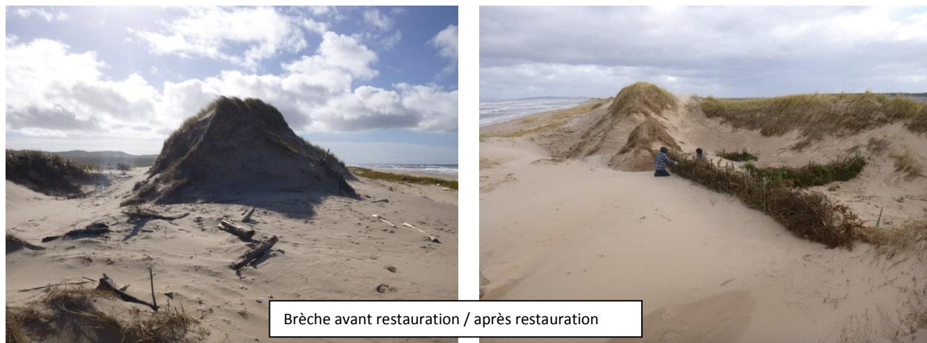
Figure 11 : Restauration par fascines multiples du site DO034
